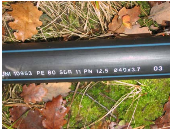
Foto: Particolare della tubazione esistente dell'acquedotto esterno Castel Restor.
