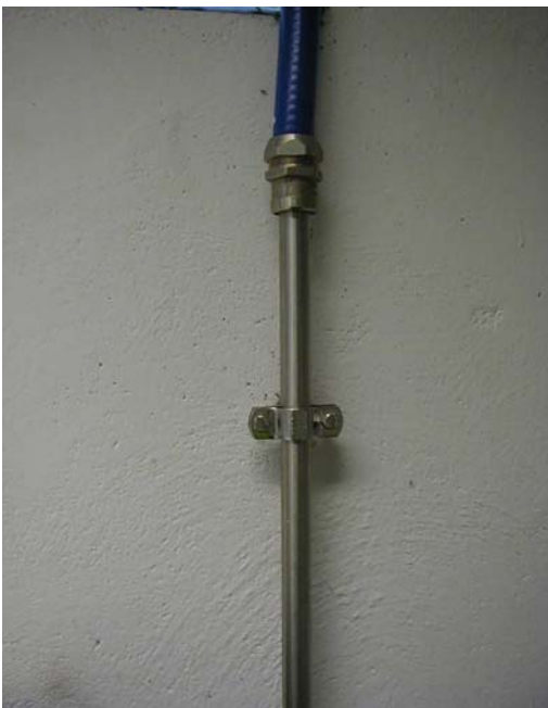
Foto 1 - Esempio di tubo in acciaio inox e guaina metallica rivestita in PVC
