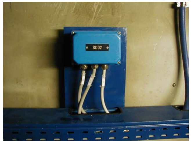
Foto 2 - Esempio di installazione di una scatola di derivazione con pressacavi metallici sulla canalina portacavi
