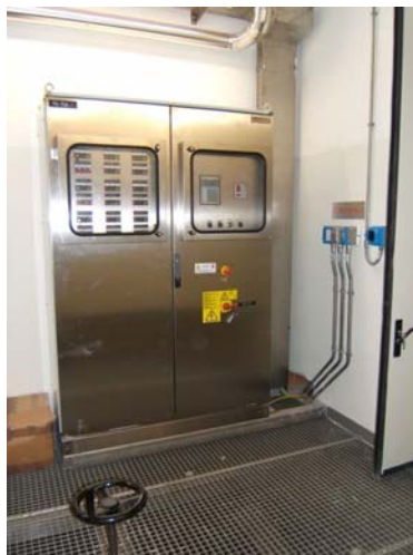
tipico quadro package in campo il grado di protezione IP55 garantito dalla controporta
